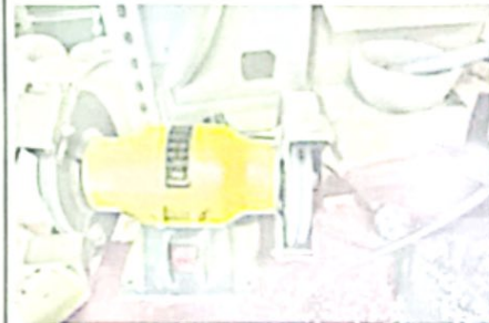
小砂轮机未固定，无安全标识，无安全操作注意事项
